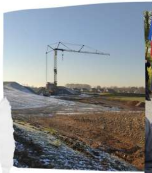
Travaux de la future passerelle route d'Argence
