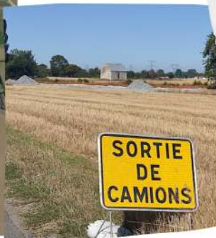
Démarrage des travaux Chemin du Marais
